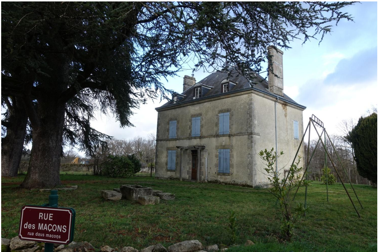
Bersac-sur-Rivalier, belle demeure rue des maçons.
