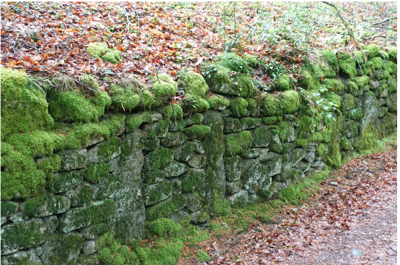
Saint-Léger-la-Montagne, Sauvagnac, restes d'un muret de pierres sèches.
