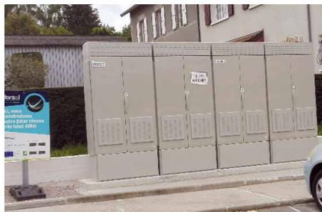
Pour Bonnac, une fibre optique a été tirée du central de Beaune-les-Mines jusqu'à un Sous-Répartiteur (SR) implanté Place de l'Europe, à côté de la boucherie. L'armoire de
